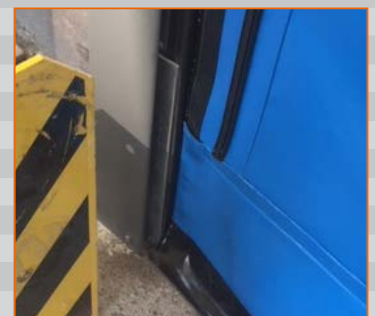
Führungsschiene mit Zip-System und Flex-Edge-Schließkante
